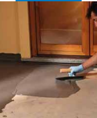
Hidroizolarea unei terase aplicând materialul cu fierul de glet
