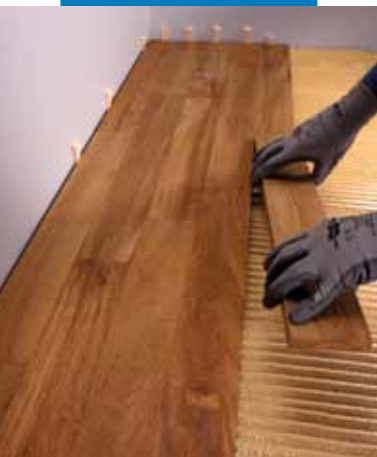
Montare de parchet cu dimensiune mare
