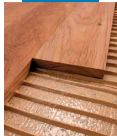
Lipire de parchet pe adeziv conform standardelor
