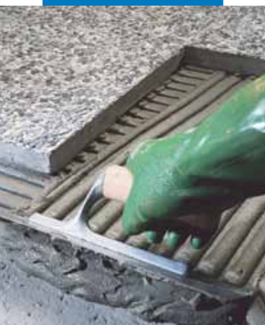
Montarea la exterior a plăcilor profilate de granit
